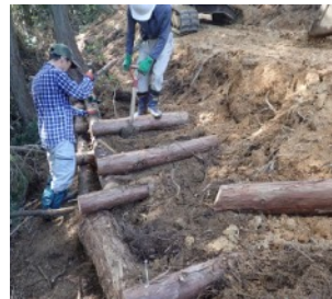
盛り土が多い場所は路肩補強 (仕上げでは全て土に埋まる)
