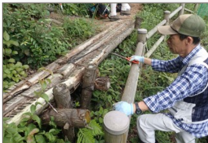
北部湿原脇観察コース丸太橋の補修 8/28
