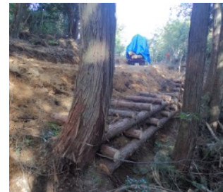
盛り土が多い場所は路肩補強 (仕上げでは全て土に埋まる)
